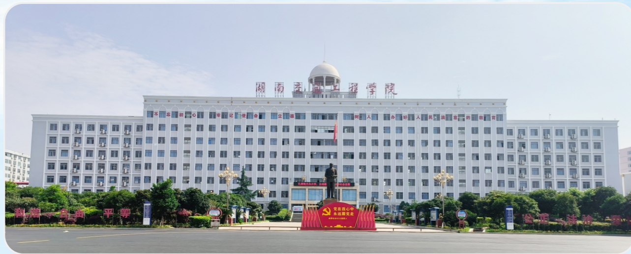
万人教学大楼
