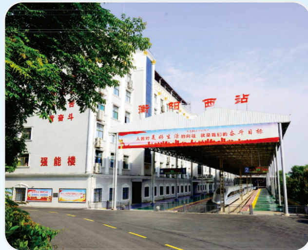
模拟高铁站台实训中心一角
