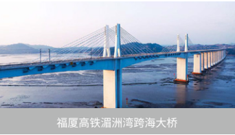
福厦高铁湄洲湾跨海大桥
