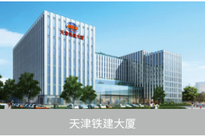
天津铁建大厦
